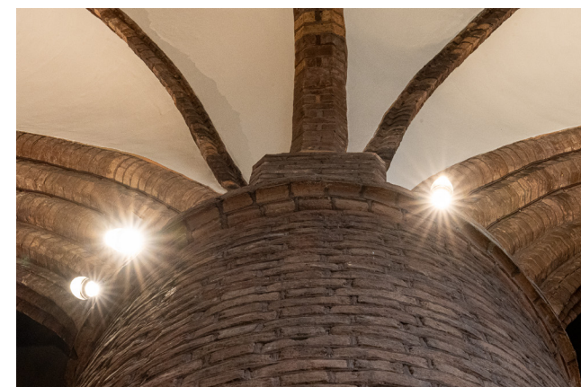
LED-Lampen – mit Trafos auch dem Dachboden
