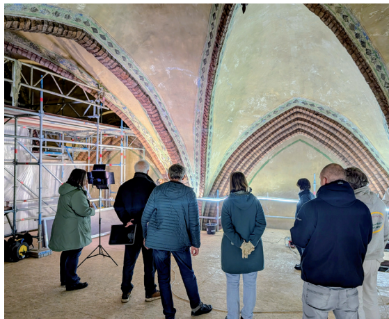
Große Baubesprechung mit Kirchengemeinde, Kirchenkreis und Landeskirche: Was soll geschehen mit der Farbfassung aus der Mitte des 19. Jahrhunderts?
