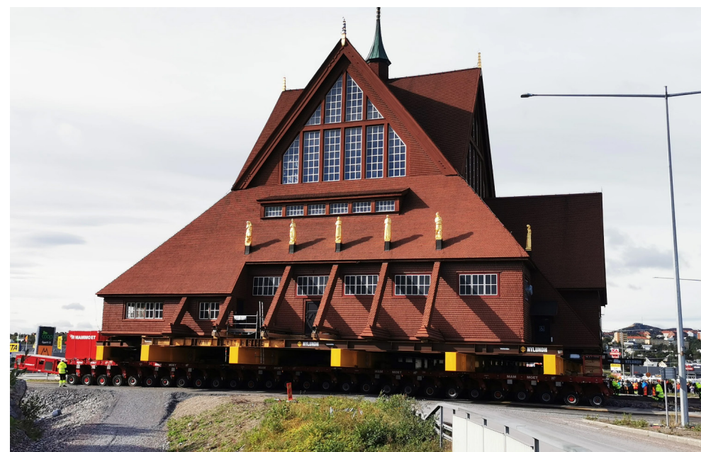
Die Kirche von 1912, Wahrzeichen von Kiruna, ist im August umgezogen.
