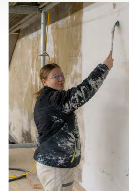
Die Auszubildende Leonie Trahm beim aufbringen der ersten Kalkschlämme
